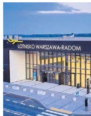
Terminal Portu Lotniczego Warszawa Radom.
