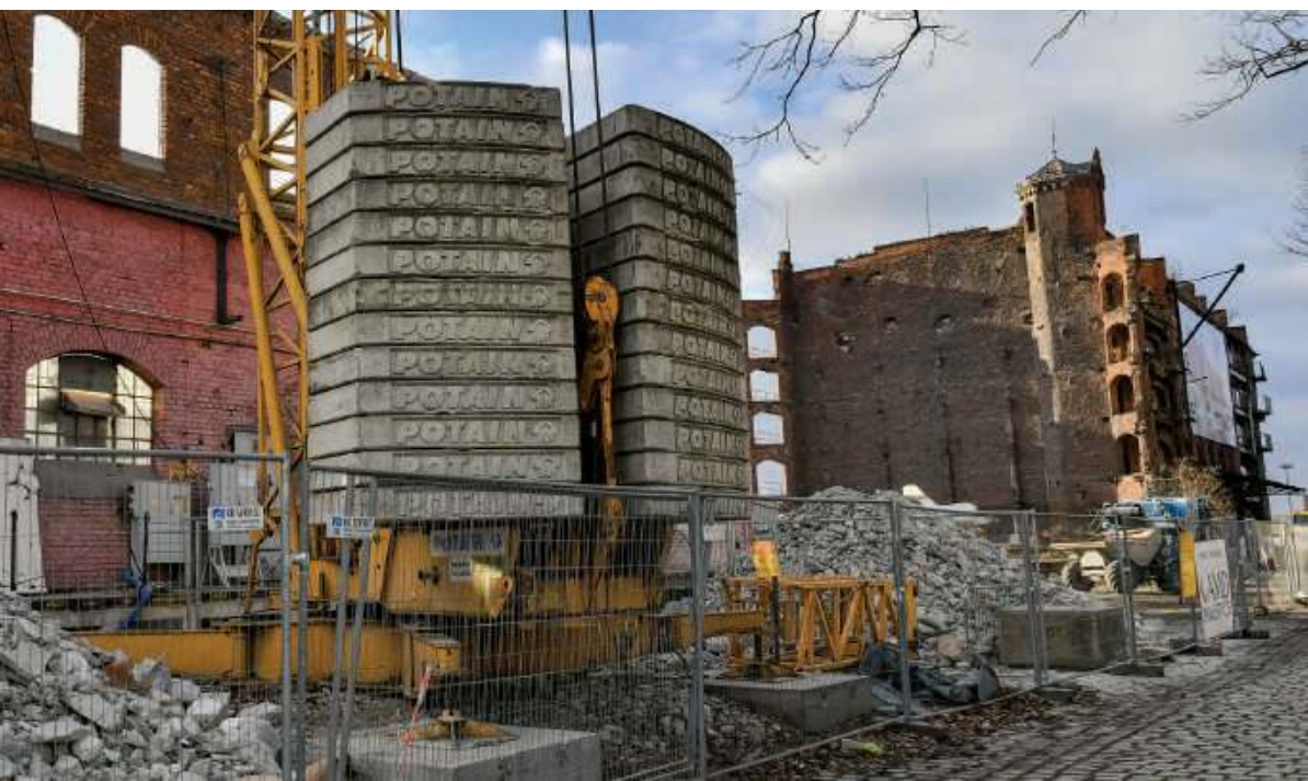
Rozbiórka zabytkowych budynków w Porcie Miejskim we Wrocławiu | fot. Janusz Gajdamowicz/Gazeta Polska
