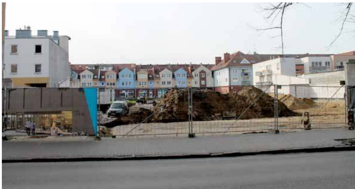
Na placu budowy trwają prace
