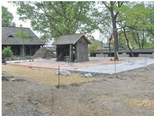
W skansenie prowadzone są roboty
