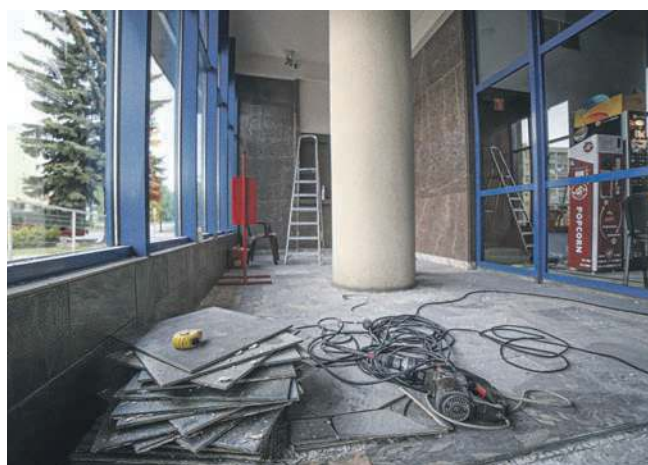
MOKSiR wykorzystał czas zamknięcia ośrodka na porządk i remonty
