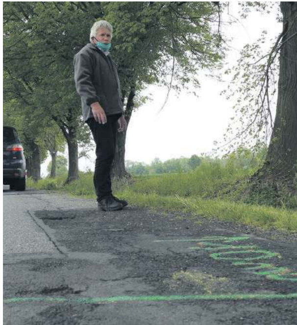
- Rów przydrożny został pogłębiony do granicy z powiatem ząbkowickim – mówi Ryszard Przyszlak, sołtys Mnikowa
