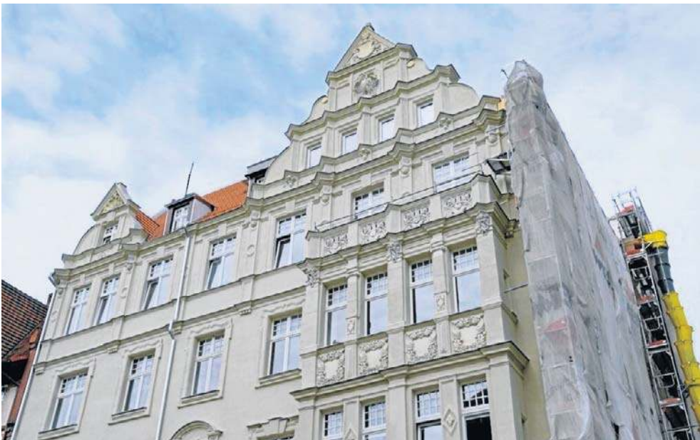
Odrestauirowana kamienica „Pod Kogutem” przy ul. Poniatowskiego 5 to perła dawnego Wilhelmstadt, czyli przedmieścia św. Katarzyny w Toruniu
