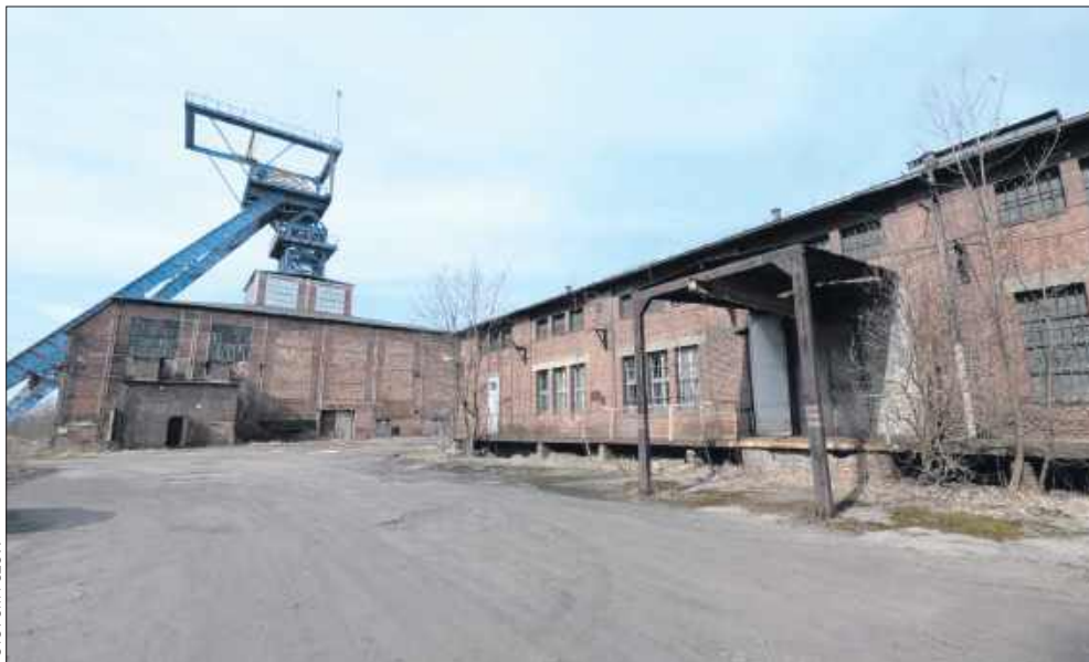
■ W kolejnym etapie rewitalizacji prace mają objąć były magazyn główny kopalni oraz nadszybie szybu Chrobry I.
