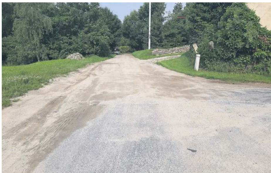
Remont ulicy Tęczowej rozpocznie się przy odcinku drogi asfaltowej
