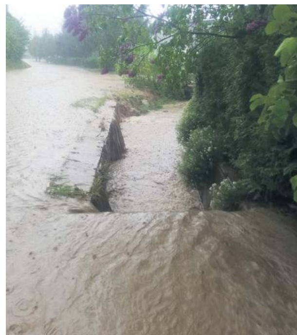
Po ostatnich ulewach w Gościęcicach droga zamieniła się w rwący potok
