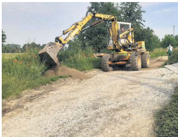
Ekipa drogowców utwardza podłoże pod ułożenie betonowych, ażurowych płyt
