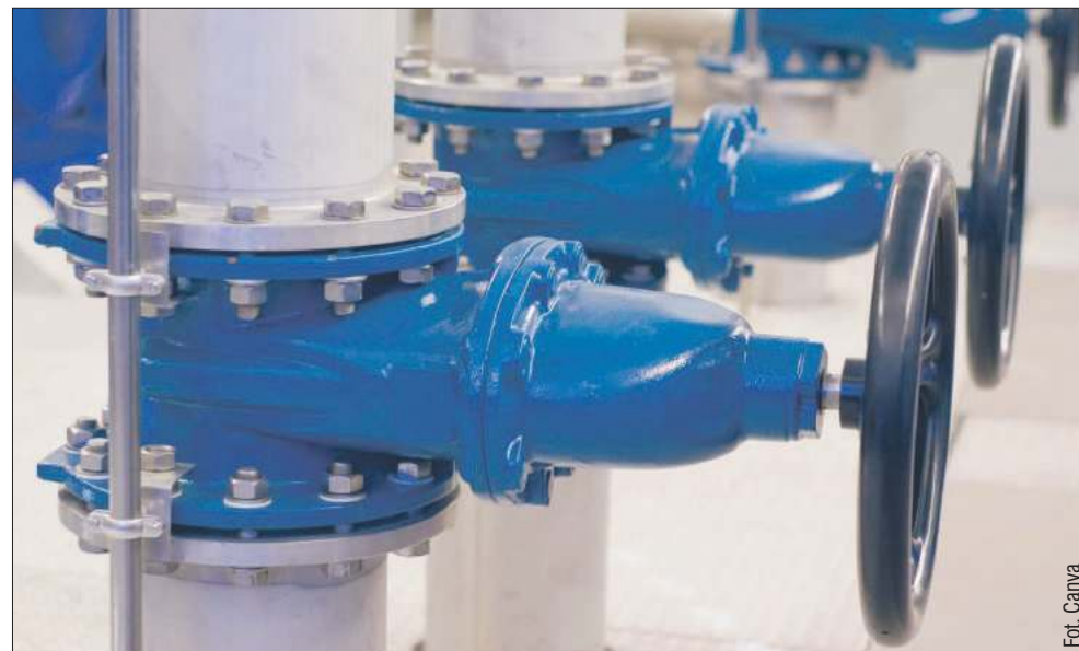
Powodem wyłączenia wody w całej gminie będzie wymiana zasuw na przepustnice.
