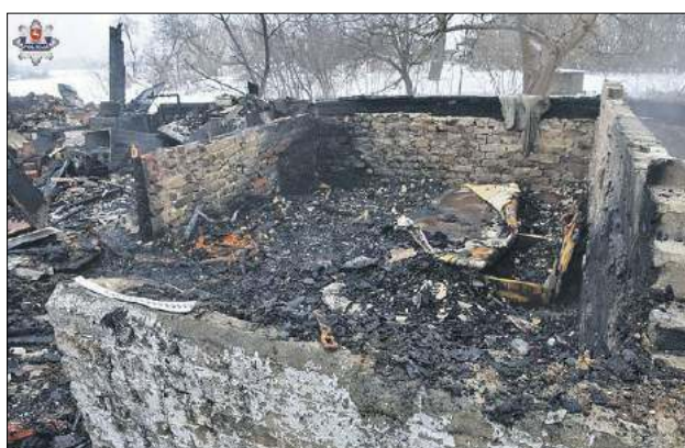
Na szczęście mężczyznom udało się wydostać na zewnątrz palącego się domu. Z oparzeniami ciała zostali przewiezieni do szpitala
