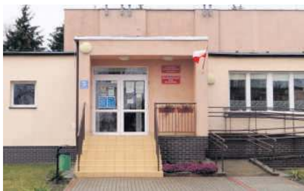
Remont dachu GCK-E w Borku Strzeleńskim będzie kosztował ok. 90 tys. zł. Foto: GBP Borów
