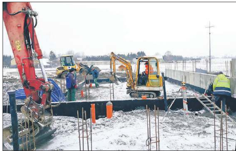
Przebudowę oczyszczalni w Zawadzie zajmuje się konsorcjum firm: Instalbud z Rzeszowa i Fambud ze Skierniewic.
