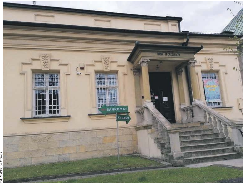
Na głównej siedzibie banku przy alei Henryka w Chrzanowie zostanie w tym roku zamontowana instalacja fotowoltaiczna
