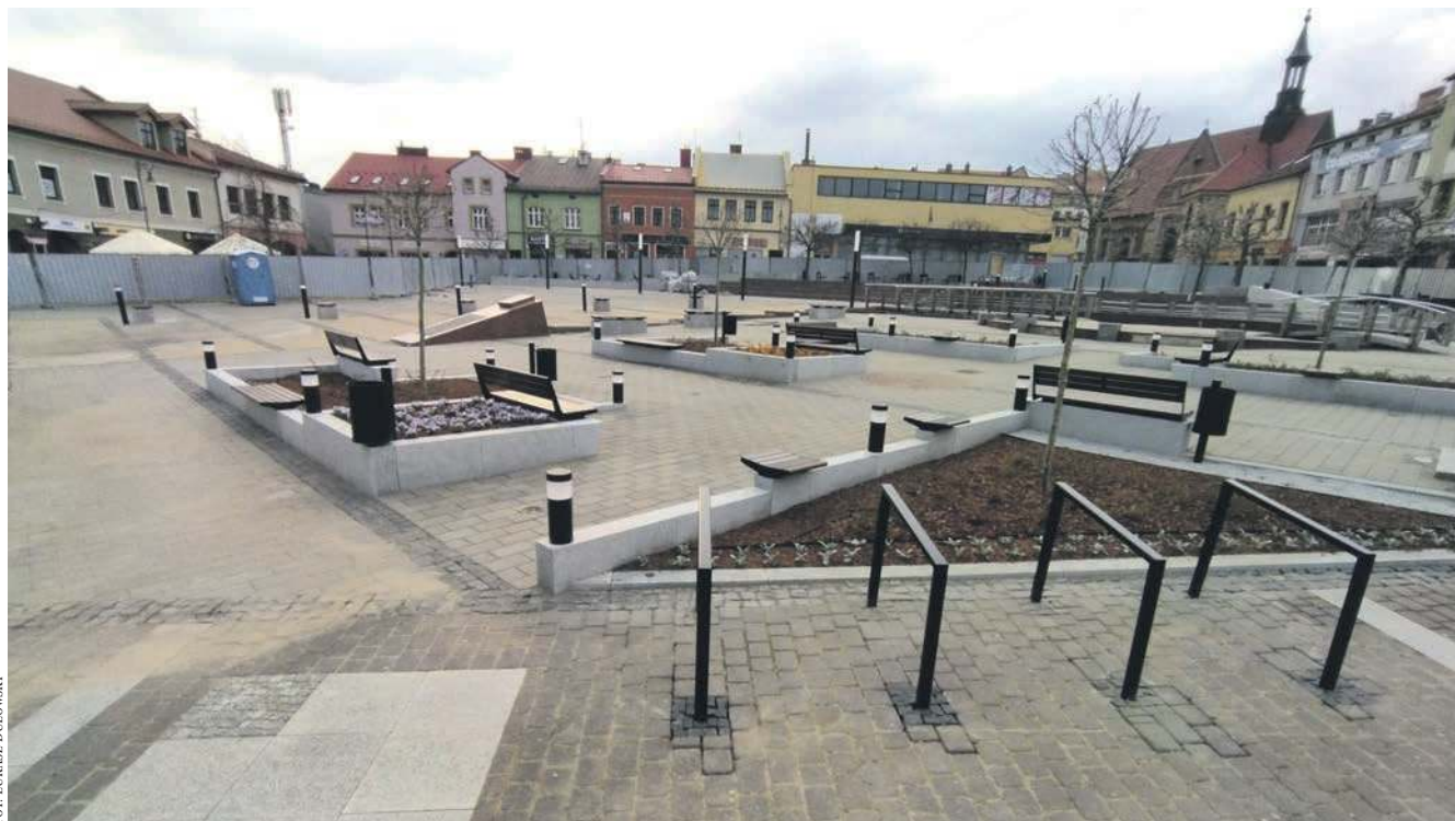
Rynek w Chrzanowie wciąż jest placem budowy
