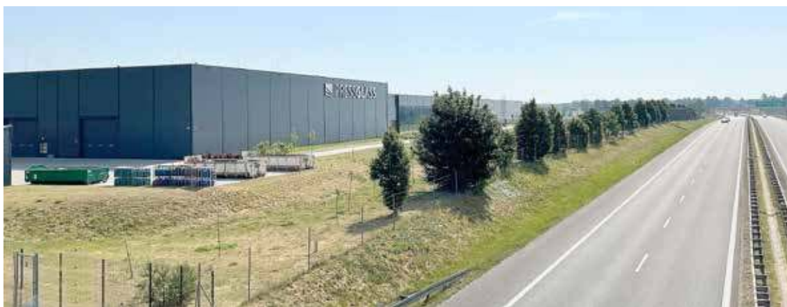
Prace nad budową drugiego po PRESSGLASS zakładu w strefie kontynuowane są jak dotąd bez przeszkód
