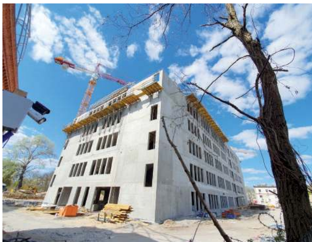
Budynek szpitala osiągnął już docelową piątą kondygnację
