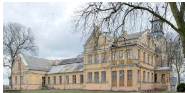
1 września 2018 r. budynek pałacowy został wyłączony z użytkowania z przyczyn technicznych
