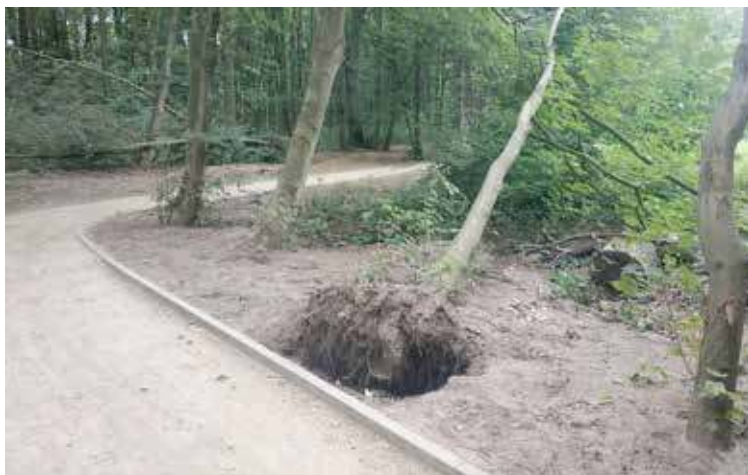
Część drzew w trakcie prac przy ścieżce musiała zostać usunięta
