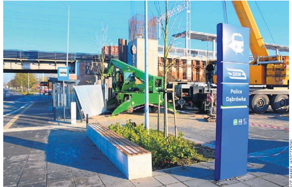
Na przystanku Police Dąbrówka kontynuowana jest budowa szybów windowych, a na peronach zamontowane zostały już wiaty przystankowe
