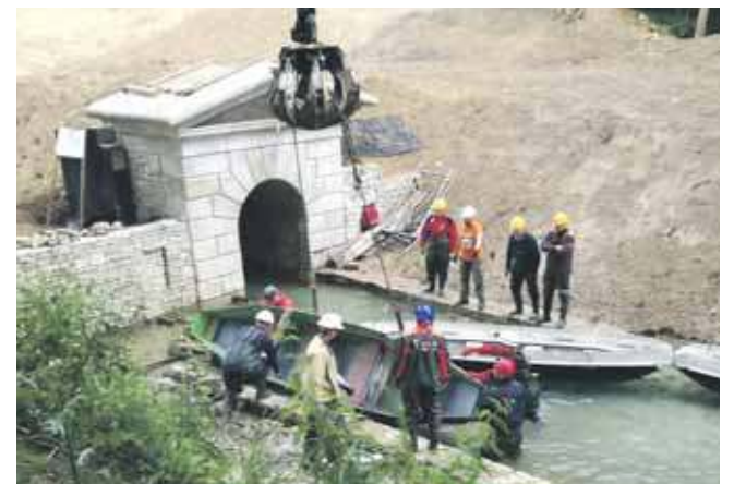
Moment wodowania nowej łódki w roznosie Głębokiej Sztolni Fryderyk. Stamtąd cały komplet przeholowano pod szyb, skąd 11 lipca popłynęli w trasę pierwsi turyści
