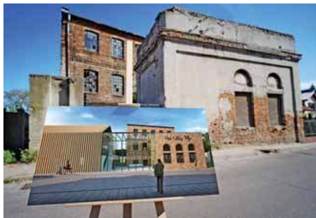
Wizualizacja inwestycji na tle obecnego stanu budynku
