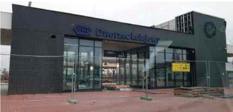
Choć budynek dworca wygląda na ukończony, okazuje się, że nie wszystkie prace zostały już wykonane i na jego otwarcie pasażerowie będą musieli poczekać jeszcze prawdopodobnie kilka miesięcy
