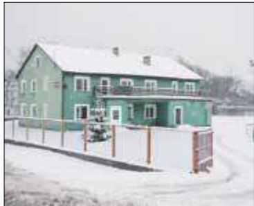
W wyremontowanym hotelu powstaną pomieszczenia, które będzie użytkował miejscowy ośrodek kultury. Będzie się również w nim mieścić kafejka internetowa
