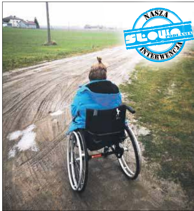
Wójt gminy Leśna Podlaska zapewnia, że droga do pani Edyty będzie utwardzona kamieniem łamanym, jednak trzeba chwilę zaczekać
