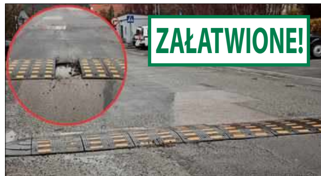
Uszkodzony próg zwalniający na ul. Myśliwca w Zdzieszowicach jest już naprawiony.
