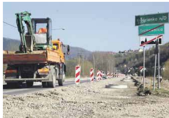
Przebudowa drogi Krościenko-Szczawnica trwa w najlepsze.
