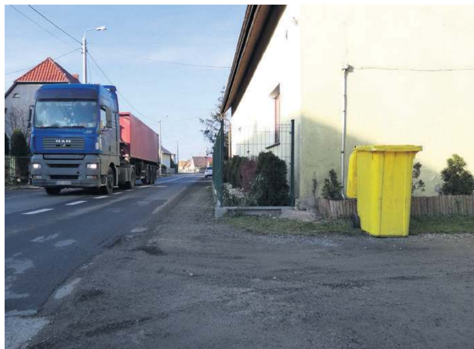
Z powodu braku chodnika, przejeżdżające tiry stanowią zagrożenie dla pieszych
