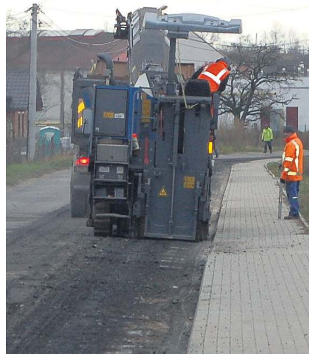
Choć remontowany odcinek w Szczawinie nie jest długi, to dla mieszkańców tej miejscowości ma on duże znaczenie
