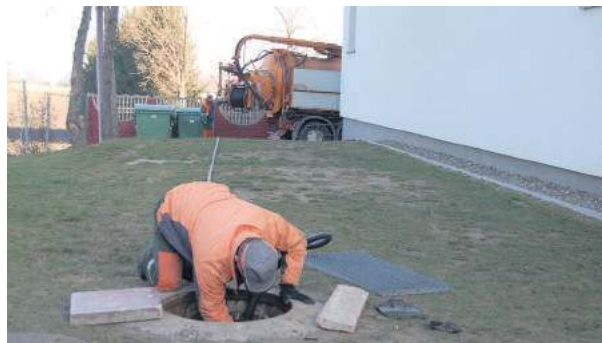
Pracownicy ZUK-u Łagiewniki przy pomocy WUKO udrożnili główne rury kanalizacyjne
