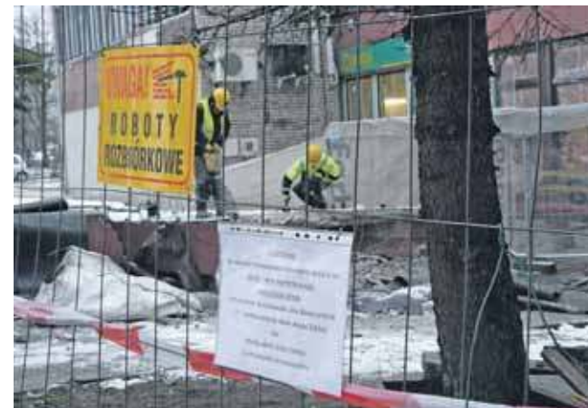
W miejsce rozebranych schodów z estakadą mają powstać klatki schodowe
