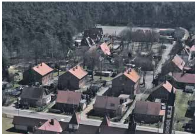
W niezłym stanie zachowała się Kolonia Fabryczna w Boruszowicach
