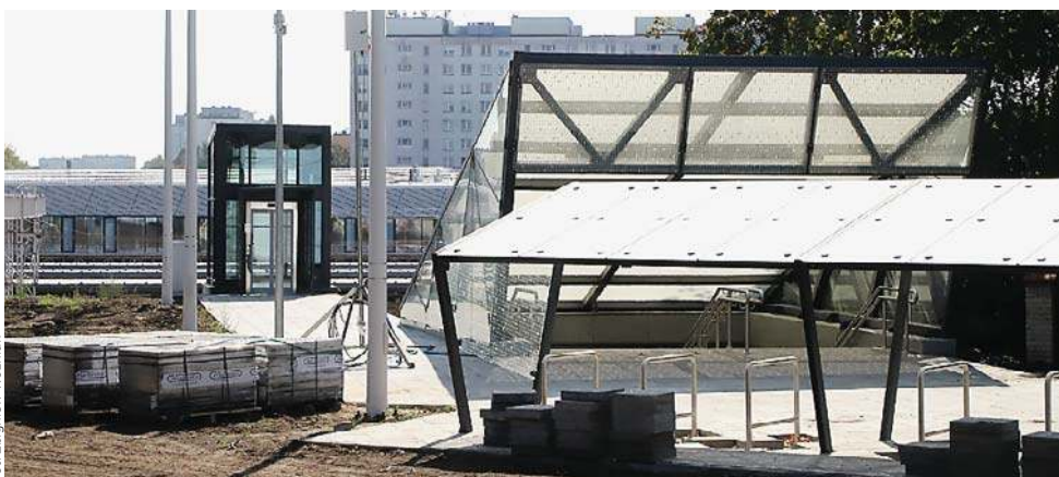
Wejście do tunelu od strony Zatorza
