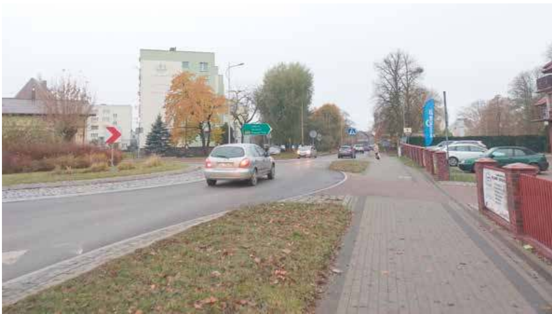
Radni dali zielone światło na rozpoczęcie prac w zakresie instalacji monitoringu
