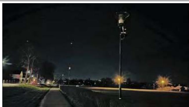
Lampy przy ścieżce rowerowej nie świecą.
