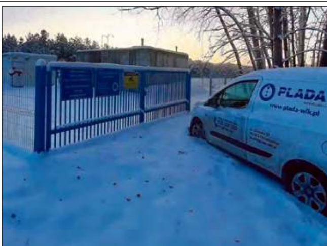
Stacja uzdatniania wody w Chrzastowicach.
