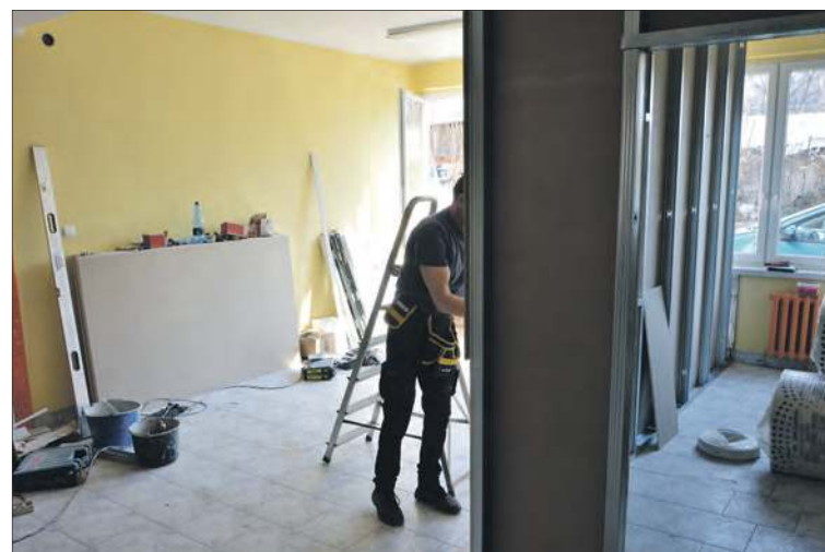
Przyszła przychodnia POZ jeszcze w trakcie remontu
