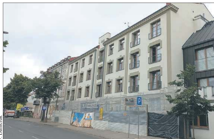
Prace budowlane przy ul. Sienkiewicza 46
