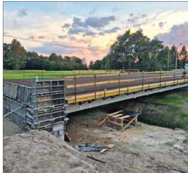
Prace idą pełną parą!
