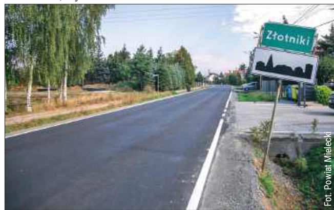
Nowa nawierzchnia w Złotnikach.
