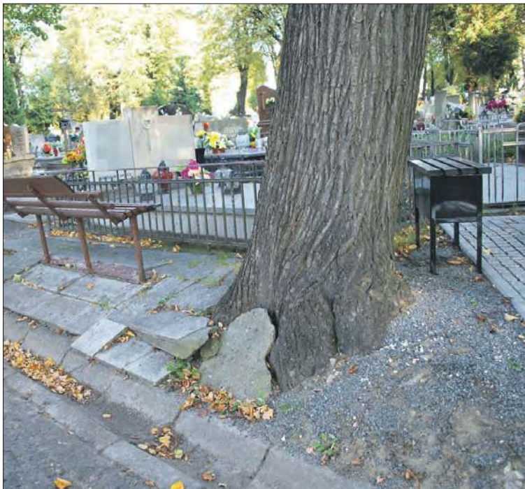
Betonoza na cmentarzu
