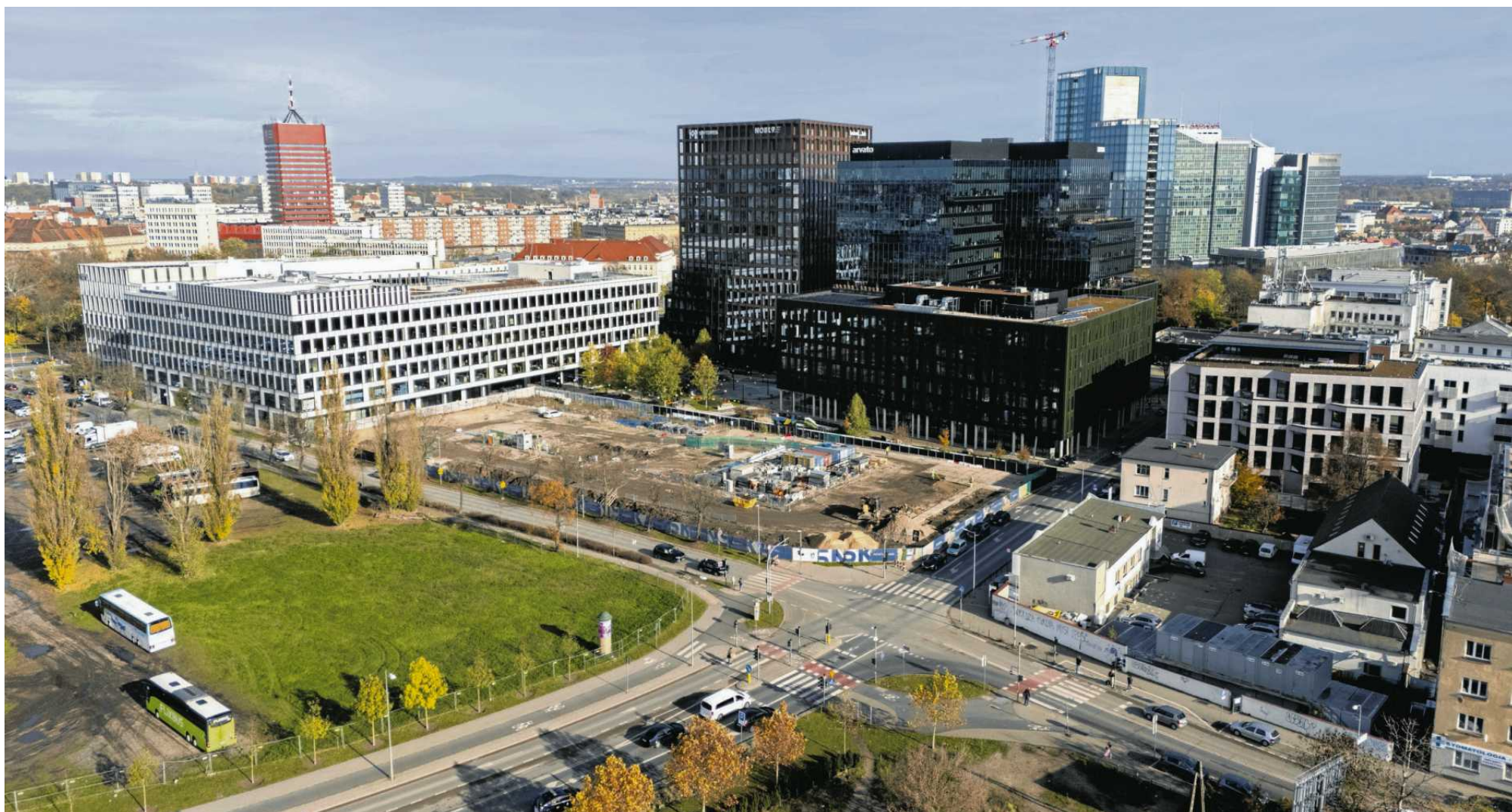
• Poznań, Nowy Rynek. Biurowce, przy których firma Skanska rozpoczęła budowę zeroemisyjnego budynku z lądowiskiem dla dronów transportowych na dachu
