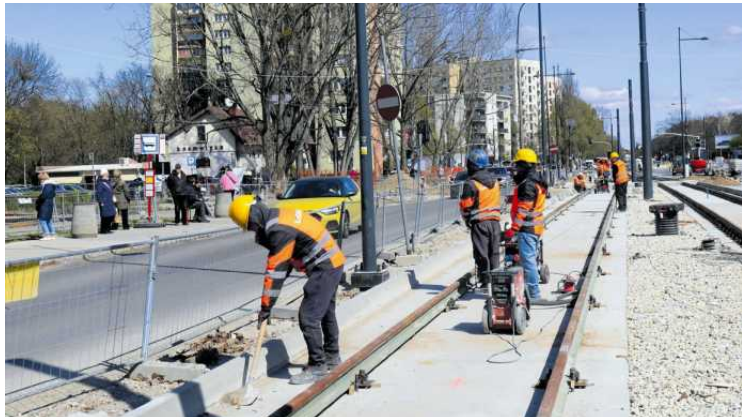
• Budowa linii tramwajowej na ul. św. Bonifacego
