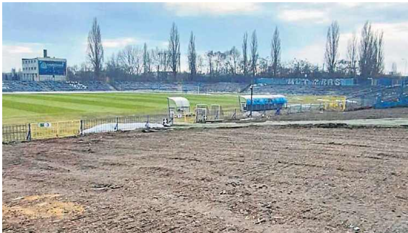
Tak wygląda dziś miejsce, w którym stała główna trybuna obiektu Ruchu Chorzów
