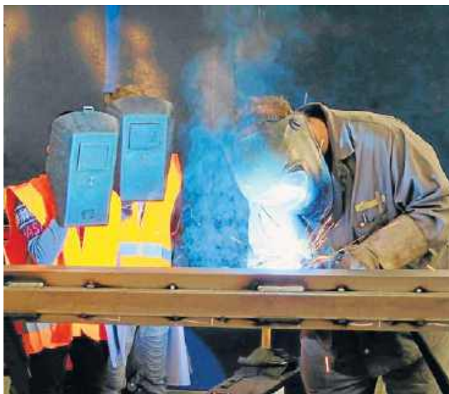
Na liście są również zawody fizyczne i techniczne związane z budownictwem i infrastrukturą. To m.in. spawacze i operatorzy robotów spawalniczych
