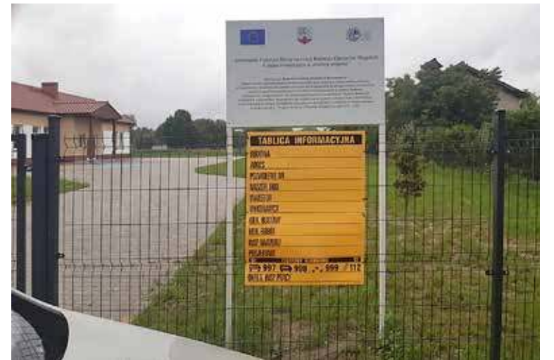
Budowa odbyła się z pomocą środków finansowych pochodzących z PROW
