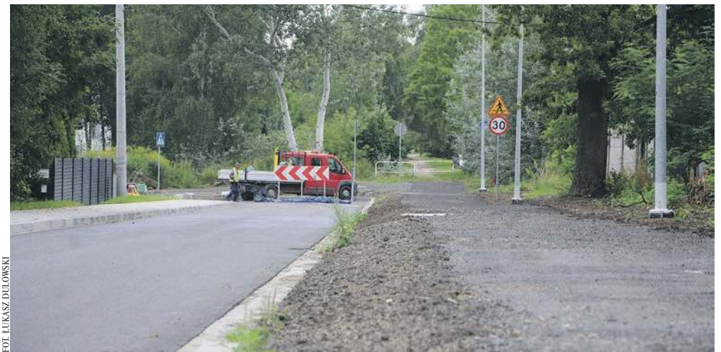
Ścieżka pieszo-rowerowa z destruktu na fragmencie Łowieckiej w Chrzanowie
