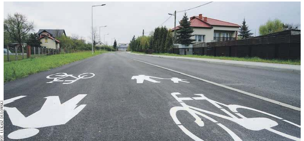
„Autostrada” dla pieszych i rowerzystów na Podleśnej w Chrzanowie
