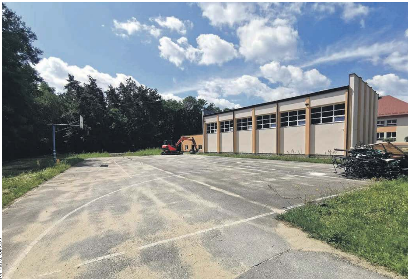
Boisko ze sztuczną nawierzchnią ma powstać w miejscu asfaltowego. Po prawej nowa sala gimnastyczna
