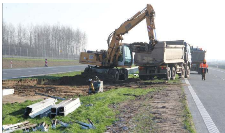
Przed Kołbielą powstaje przebieżka umożliwiająca wjazd od Warszawy na jezdnię w kierunku Lublina.
