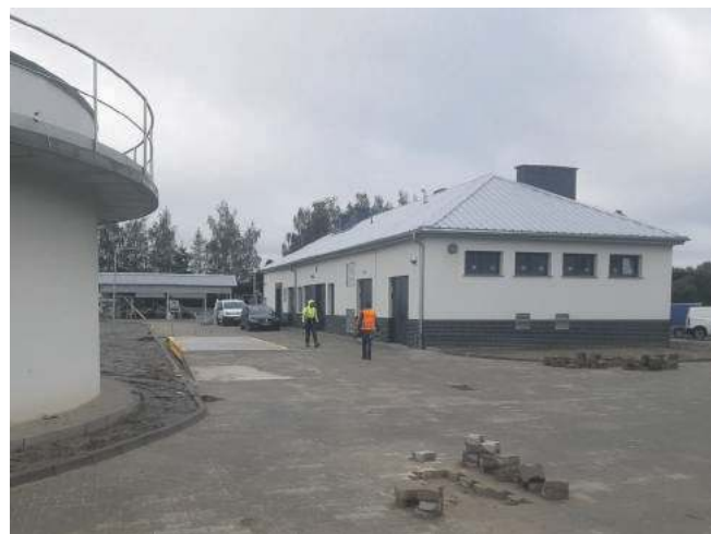
Na terenie oczyszczalni ścieków w Strzeszowie trwają ostatnie prace w zakresie zagospodarowania istniejącego terenu
