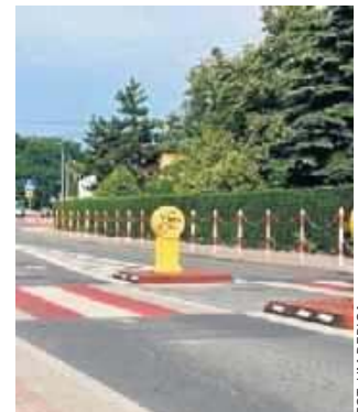
Zmodernizowane przejścia dla pieszych w Dębicy
