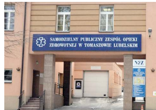
W szpitalu trwają właśnie inwestycje na łączną kwotę blisko 30 mln zł.
