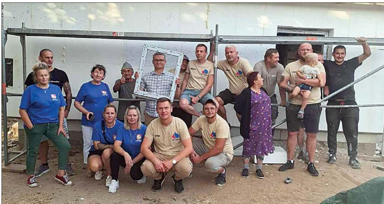
Społeczność Zabiela podjęła wyzwanie. Remontują dom sąsiadce, który po zakończeniu prac będzie jak nowy!
