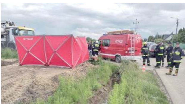
Podczas wylewania betonu operator pompy niefortunnie „zaczepił” o linie średniego napięcia. Mężczyźni, którzy w tym czasie trzymali pompę zostali porażeni prądem
