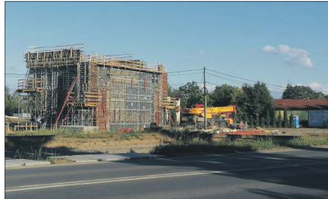
Powstaje już konstrukcja wiaduktu kolejowego, który powstaje na granicy Chorzelowa z Mielcem.
