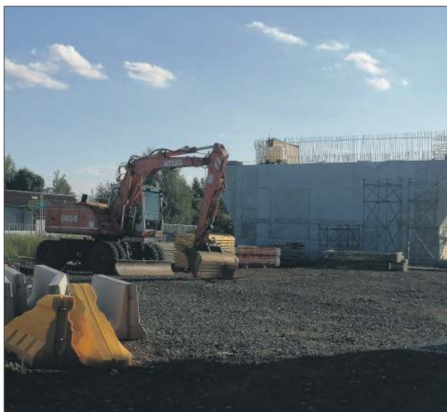
Nowa konstrukcja wiaduktu.
