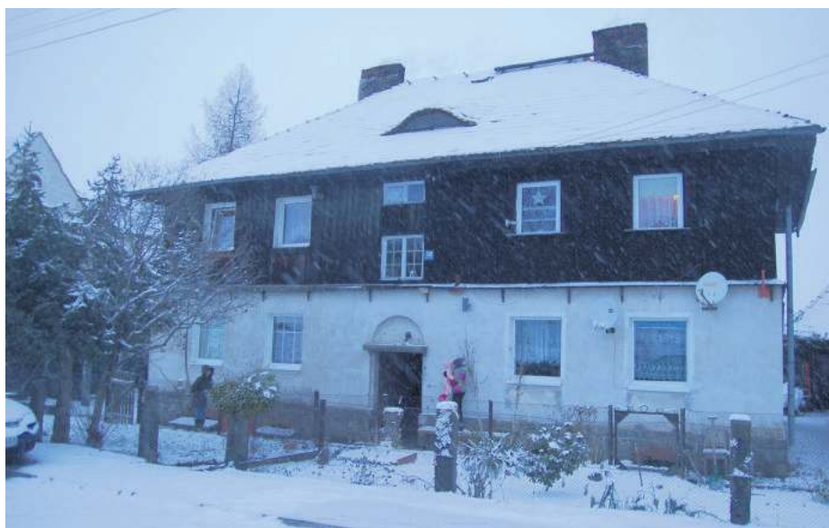
1 stycznia w jednym z mieszkań tego wielorodzinnego budynku wybuchł pożar
