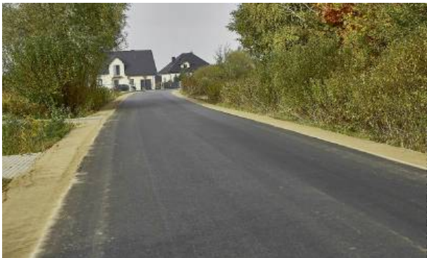
Inwestycja znacząco poprawiła stan oraz wygląd drogi.
