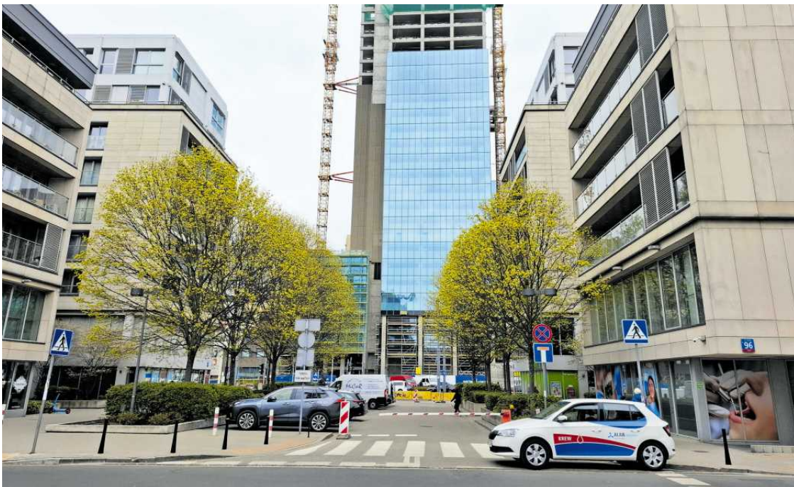
• Skrzyżowanie ulic Pańskiej i Miedzianej. Odcinek Miedzianej do Prostej jest zagrodzony szlabanem, służy jako parking. W tym miejscu powstanie przedłużenie Miedzianej, finansowane przez inwestora pobliskiego biurowca Office House FOT. MICHAŁ WOJTCZUK
