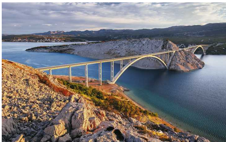
• Most Krk. Od 1980 r. łączy wyspę Krk z lądem w pobliżu miasta Kraljevica. Dwa łukowate przęsła przechodzą przez wysepkę Sveti Marko
