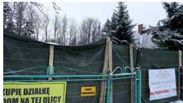
Inwestor rusza z budową na działce po wyburzonej willi „Ros-Ami”.
